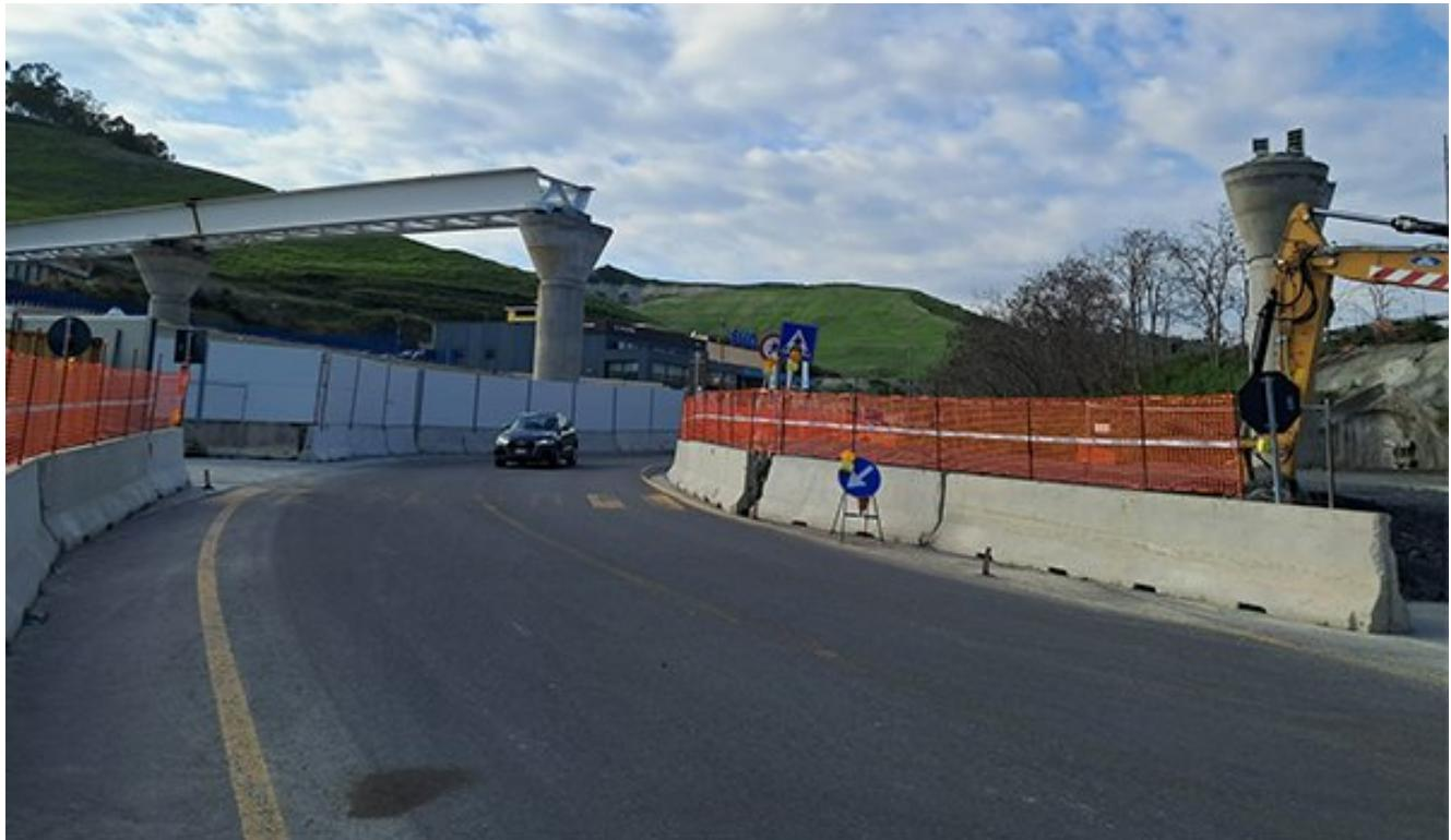
Catanzaro, lavori sulla metro di superficie: varo delle travi del viadotto della Fiumarella e chiusura temporanea di via Conti Falluc
